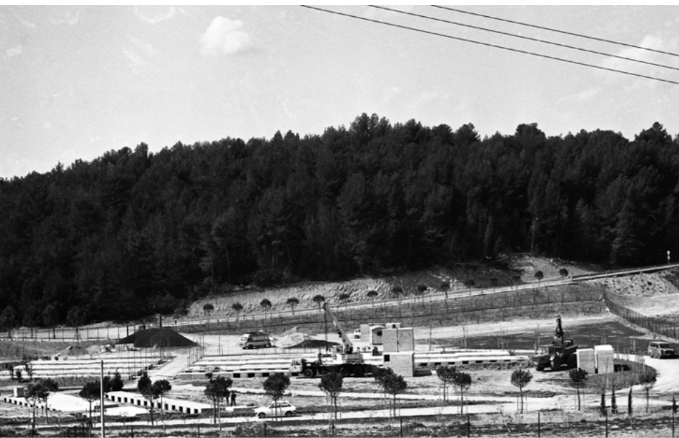
↑ Travaux d'aménagement du cimetière de Fenestrelles en 1983 (c) Archives municipales d'Aubagne
