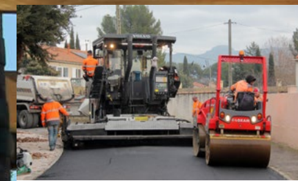
Travaux de voirie
