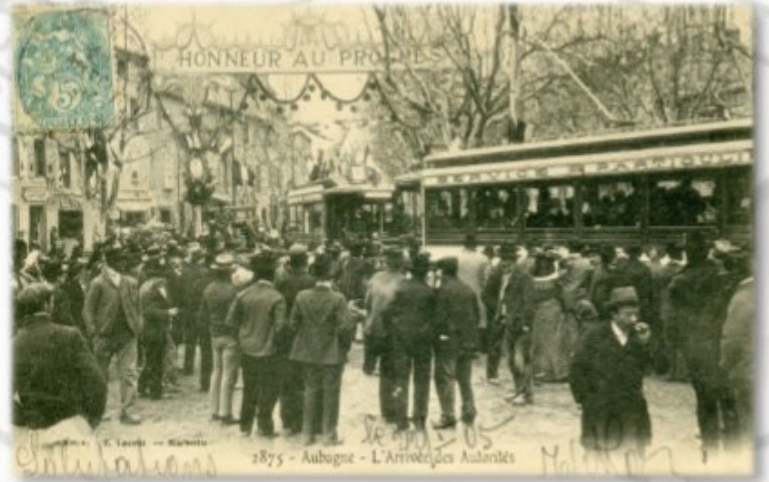
L'arrivée du tramway à Aubagne le 15 janvier 1905 au son des musiques aubagnaises © AMA, 20 Fi 235
