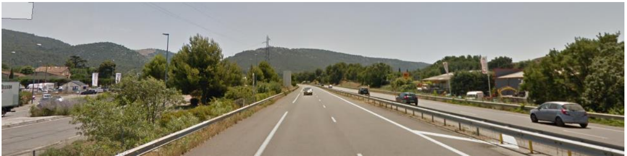
Figure 5 : Vue de l'A52 vers le Sud : à gauche, RD43c et occupations commerciales et d'activités. A droite, les deux constructions d'activités au Sud de Camp Sarlier (source Google Maps)
