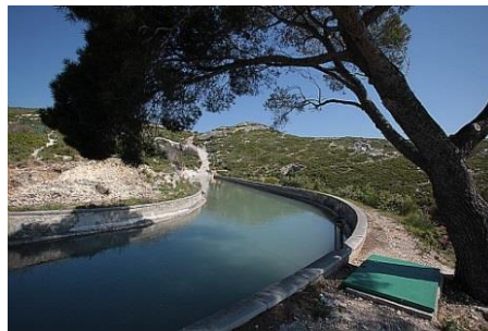
Figure 13 Le Canal de Marseille
