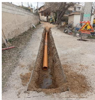
Chantier chemin de la Pérussonne
