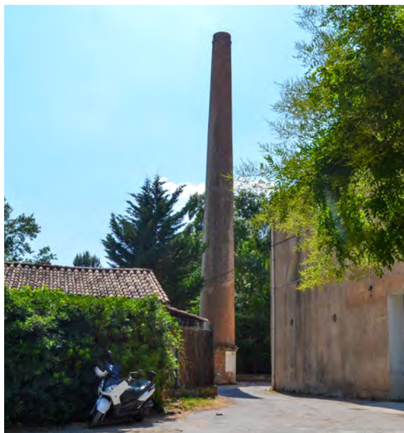
➤ Ancienne cheminée de four - Saint-Zacharie
