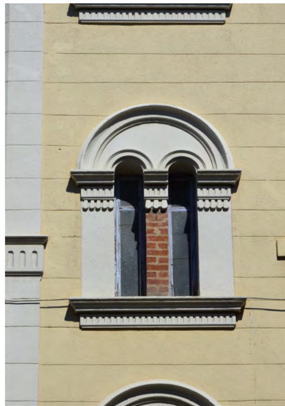
Détail d'une façade de la rue de la République
