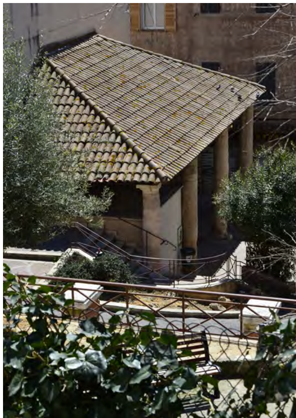
Halle de la Poissonnerie
