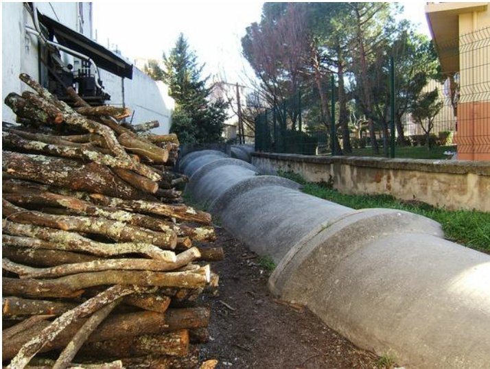
Figure 6 : Le Merlançon semi enterré dans la traversée d'Aubagne
